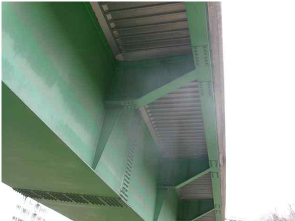
바닥판 하면 및 거더 전경
