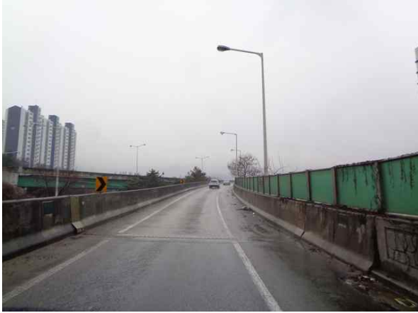
교량 상부 전경
