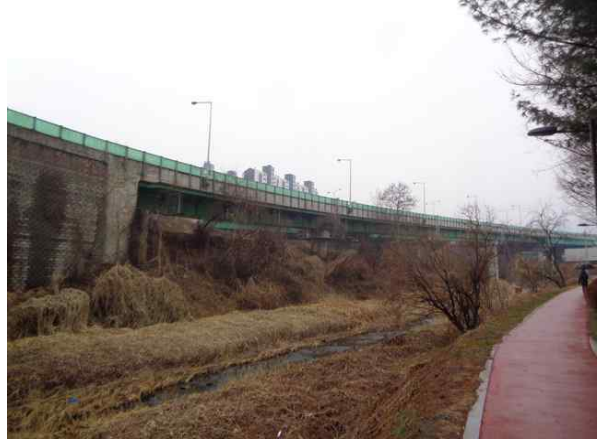
교량 측면 전경
